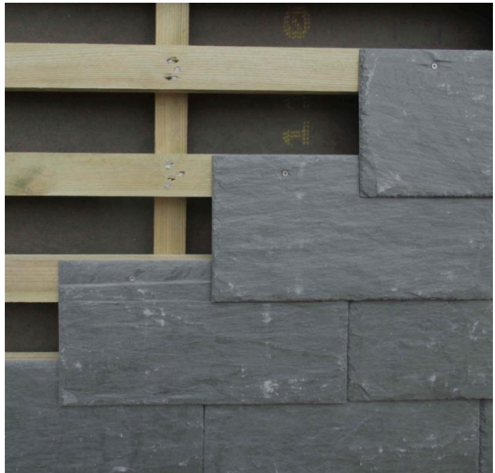
Skiffer monteret med skjult skruemontage
